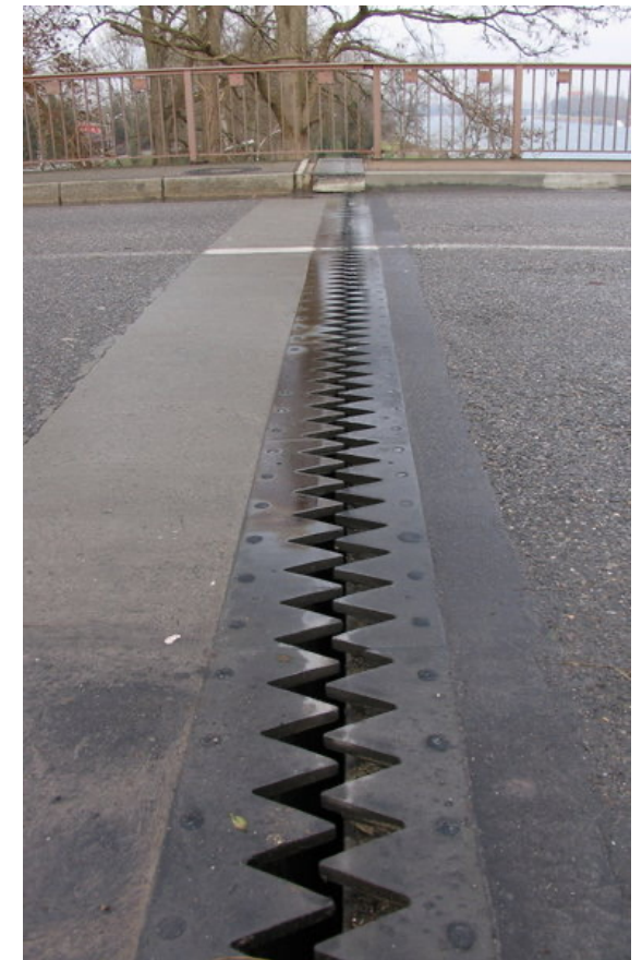
Joint de dilatation thermique d'un pont
